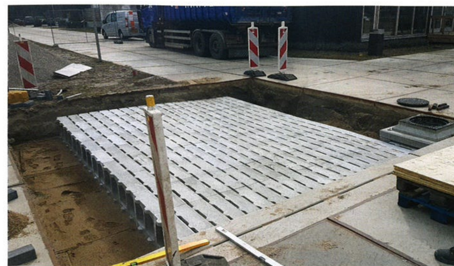
Bufferblock tijdens de aanleg.
